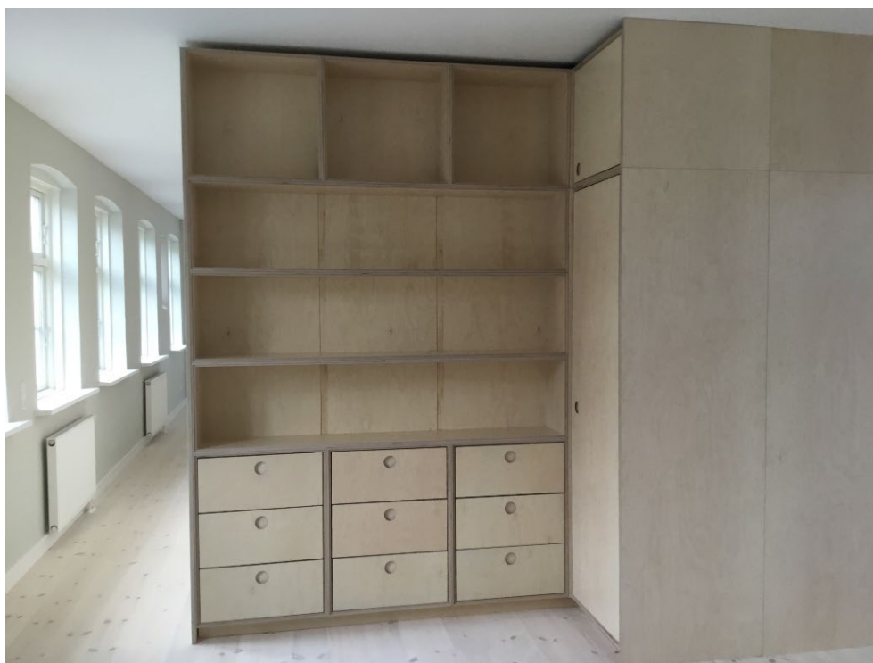
FIGUR 11. Rumdeler, der opdeler det store fællesrum på 1. sal og samtidig fungerer som et konstruktivt element. Foto: Niels Haldor Bertelsen (2020).
